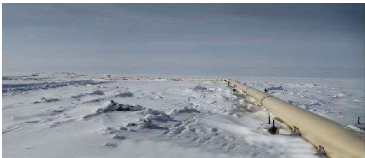
Рисунок 18 - Межпромысловый газопровод «Пелятка – Северо-Соленинское»
